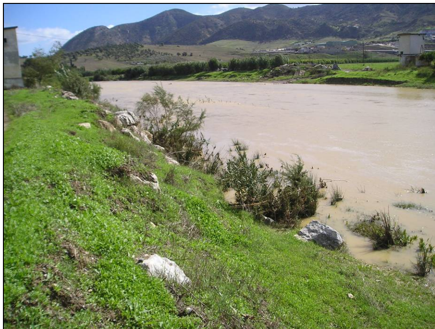
Ausencia de vegetación de ribera en tramo afectado por la construcción de una escollera.
